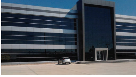
Çerkezköy 30.000 m² Fabrika
