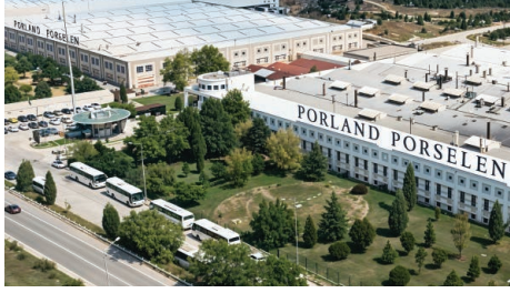
Porland Porselen Çatı Güçlendirme
